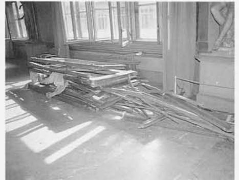
fig.13 爆風によって破れた天窓
