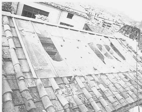
fig.13 爆風によって破れた天窓
