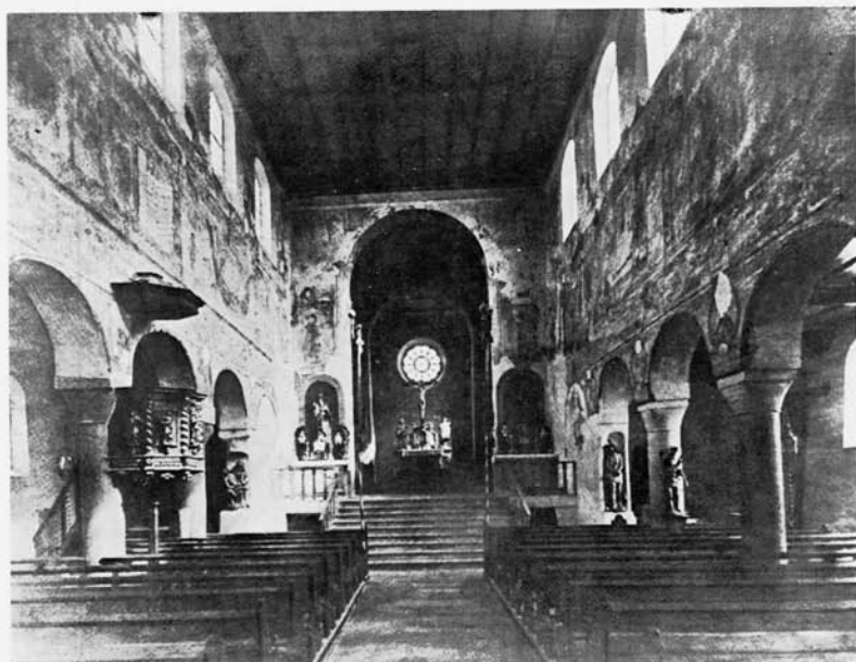
8. Aufnahme von G. Wolf. Das Mittelschiff nach Osten: Zustand nach der Freilegung der Wandmalereien (nach J. u. K. Hecht, 1979, Abb. 127)
