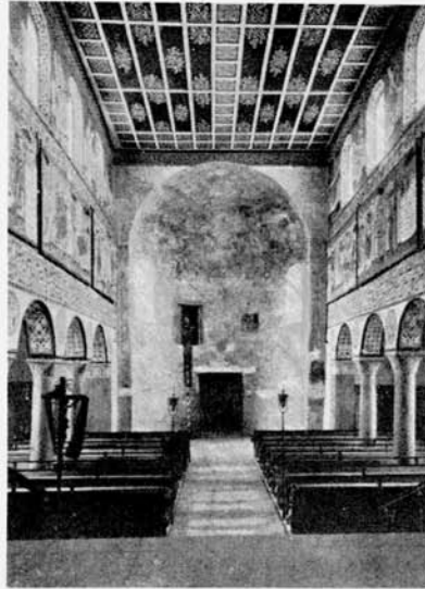
21. Das Mittelschiff nach Westen: Zustand nach der Instandsetzung um 1890 (nach G. Dehio, 1930, Abb. 33)
