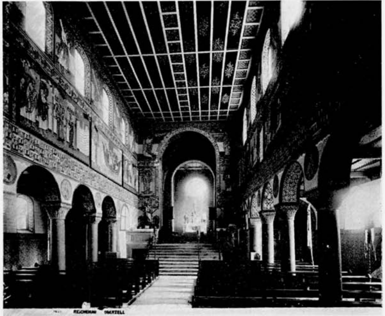
18. Reichenau-Oberzell, St. Georg. Das Mittelschiff nach Osten: Zustand nach der Instandsetzung um 1890. Aufnahme von G. Wolf (Photo: Stadtarchiv Konstanz)
