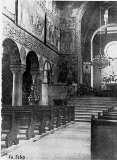
20. Das Mittelschiff nach Nord-Osten gesehen: Zustand nach der Instandsetzung um 1890 (Photo: Landesdenkmalamt Baden-Württemberg, Außenstelle Karlsruhe)
